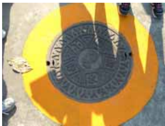
防火貯水槽は目立つように、フタの周りが黄色く塗られている
